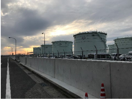
Barrière d'eau au niveau de la zone de stockage du carburant (Novembre 2020)
