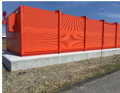
Mise à l'abri des pompes de drainage (Juin 2021)
