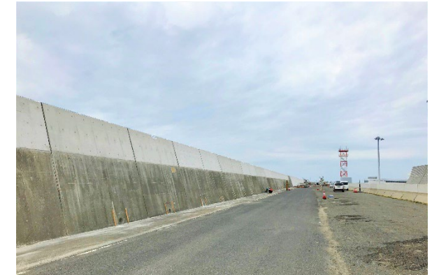
■ Réhaussement des digues (Avril 2021)
