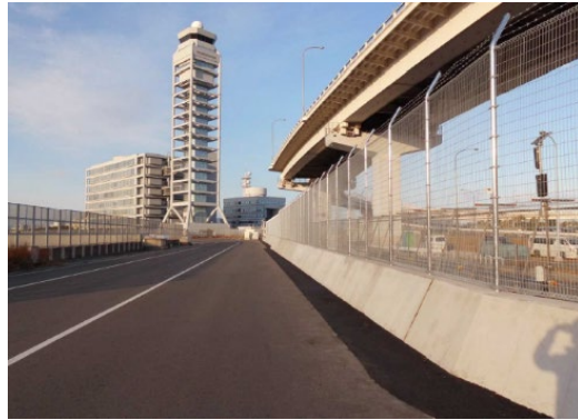
Barrière d'eau au niveau du T1 (Juillet 2021)
