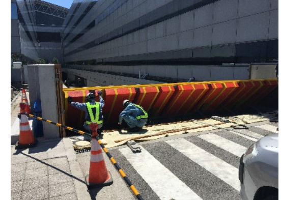
Installation de larges barrières d'eau (Juin 2019)
